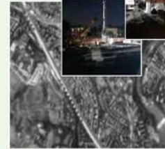
Nodo ferroviario Casalecchio di Reno
