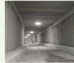
Nodo ferroviario Torino, colleg. Torino-Ceres con rete R.F.I.
